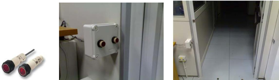
Figura 5 – Coppia di fotocellule e particolari dell’installazione al varco di accesso
